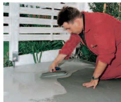
Waterafdichting PCI Seccoral 1K kan op wand of vloer gesmeerd of gespachteld worden.
